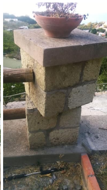
Foto 13. Frattura nel solaio di copertura e danni ai manufatti (a sinistra) con evidente rotazione di parte della colonna in mattoni di tufo (a destra).
