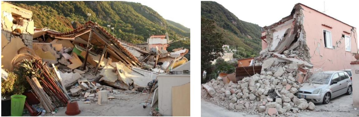
Figura 3.6-1. Casamicciola "Zona Rossa": crollo totale e parziale.
