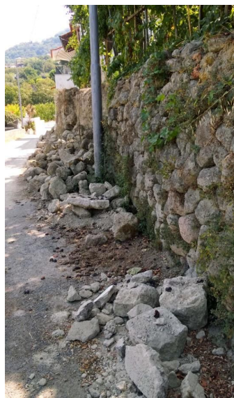
Foto 1. Crollo del muretto a secco lungo una traversa di via S. Barbara, Casamicciola.
