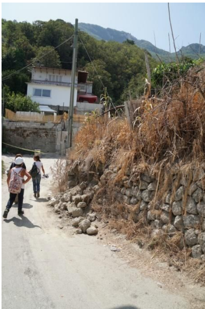
Foto 2. Fine evidenze crolli dei muretti a secco lungo una traversa di via S. Barbara, Casamicciola.
