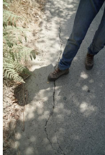
Foto 6. Frattura nell'asfalto della lunghezza di 20 m (a sinistra); dettaglio della frattura (a destra).
