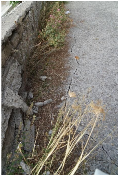
Foto 11. Frattura nell'asfalto, Via Montecito (Casamicciola).
