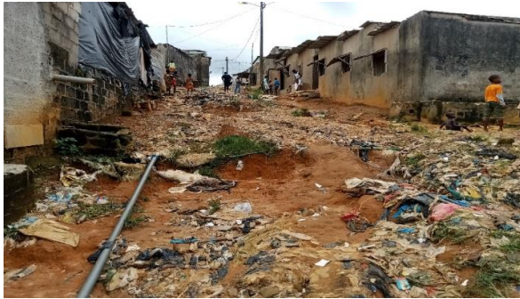
Photo n°6 : Canalisation d'eau détruite, déversement des ordures dans les creux et dégradation du sol et des habitats à Pays-Bas
