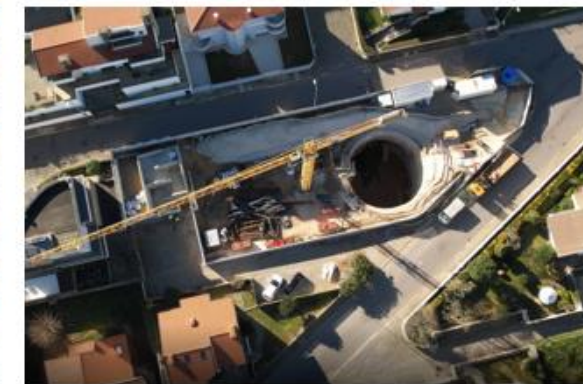
Poço Ventilação e Emergência
