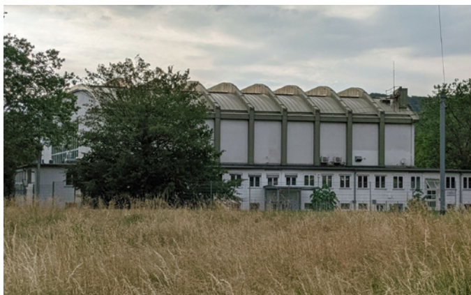
Freiburg, Stadthalle von Südosten 2023 (Bild: Maximilian Kraemer)
