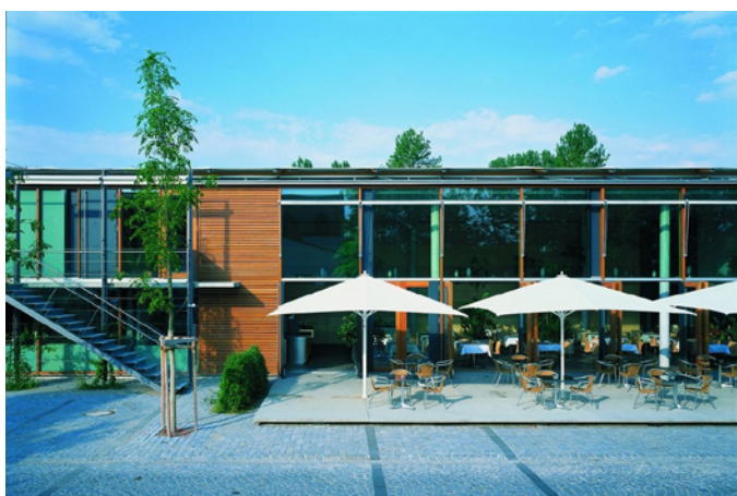
Puchheim, Kulturzentrum, Westseite zur Auferstehungskirche hin (Foto: Bernhard Friese für Lanz Architekten)
