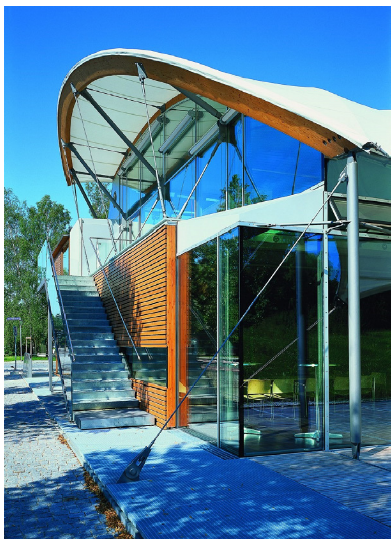
Puchheim, Kulturzentrum, Aufgang ins Obergeschoss (Foto: Bernhard Frieze für Lanz Architekten)
