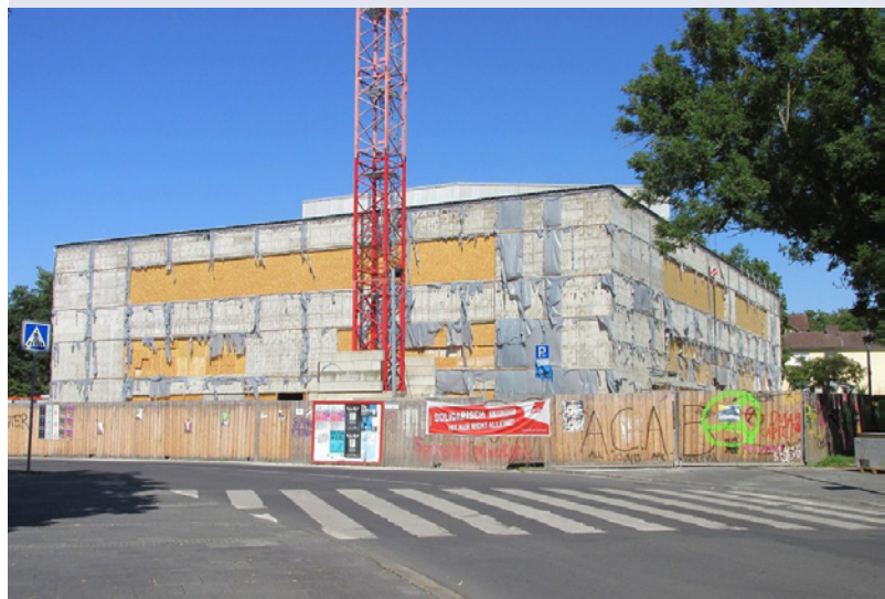
Göttingen, Stadthalle am Albaniplatz während des Umbaus im Sommer 2020 (Bild: GeorgDerReisende, CC BY-SA 4.0)
