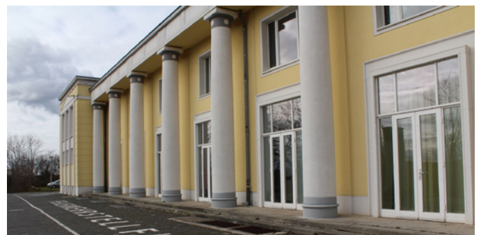
Rüdersdorf, Hofansicht 2023 (Bild: Danuta Schmidt)
