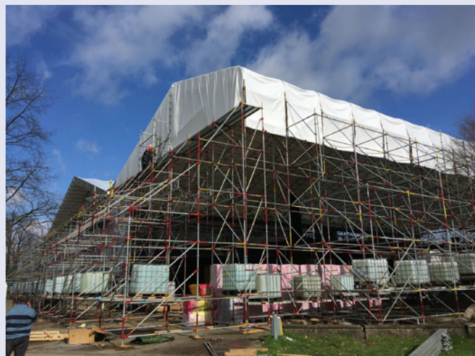
Hattersheim, Stadthalle in Einhausung 2020 (Bild: HGP Architekten)
