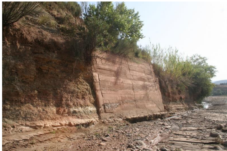
Photos N°7: Exemple d'une berge bétonnée
