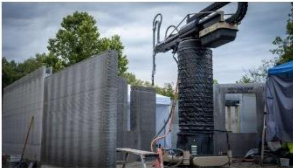
Εκ. 2. Η εφαρμογή της τριδιάστατης εκτύπωσης σκυροδέματος
