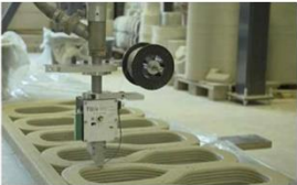
Εκ. 1. Η εφαρμογή της τριδιάστατης εκτύπωσης σκυροδέματος
