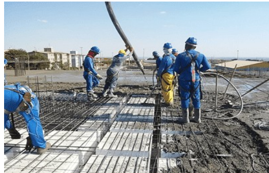
Figura 5 - Lançamento do concreto (Fonte: autoral)
