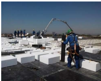
Figura 20 – Verificação dos enchimentos (Fonte: autoral)
