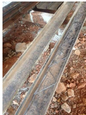
Figura 31 – Formas para vigotas treliçadas de concretos (Fonte: autoral)
