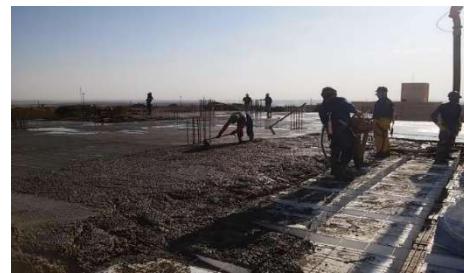
Figura 24 – Concretagem (Fonte: autoral)
