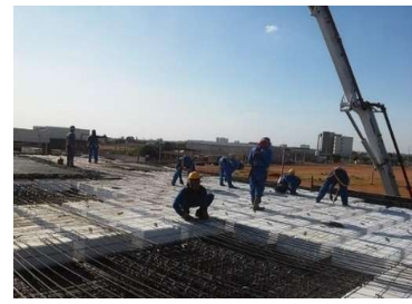
Figura 22 – Verificação das armaduras (Fonte: autoral)
