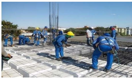
Figura 23 – Verificação das armaduras (Fonte: autoral)
