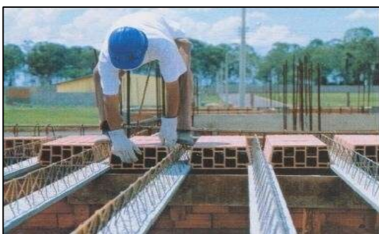
Figura 28 – Execução de lajes treliçadas [1].
