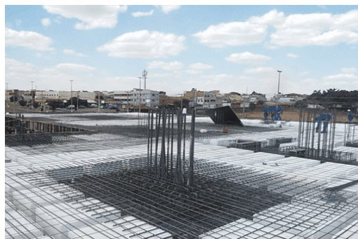
Figura 6 – Armaduras de aço (Fonte: autoral)
