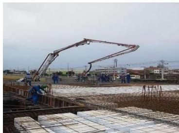
Figura 21 – Verificação das armaduras (Fonte: autoral)
