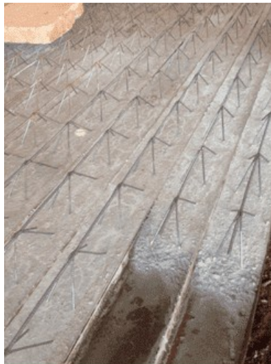
Figura 32 – Vigotas em processo de cura (Fonte: autoral)
