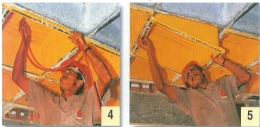
Figura 25 – Retirada dos caixotes [1].
