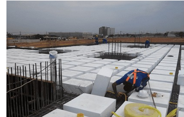
Figura 19 – Fixação dos elementos de enchimento (Fonte: autoral)
