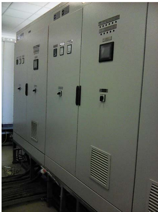
Слика 1. Два исправљача ДРИ 110-1000 (технолошке ознаке: T.36EF3 (слева) и T.36EF4 (здесна)) у објекту "С5" постројења за одсумпоравање димних гасова термоелектране "Никола Тесла А"
