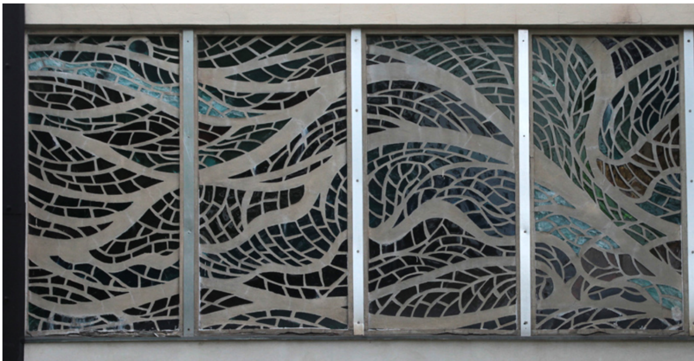
Dessau, Volksschwimmhalle, Betonglasfenster (Bild: Martin Schramme)
