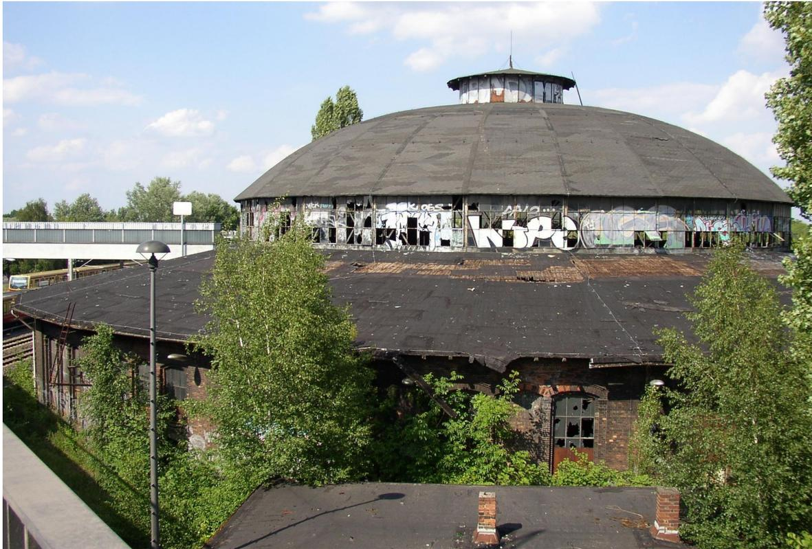
*Anno 2008 sah der Pankower Rundlokschuppen (1893) noch so aus, mittlerweile ist die Dachkonstruktion durch Vandalen stark beschädigt*
