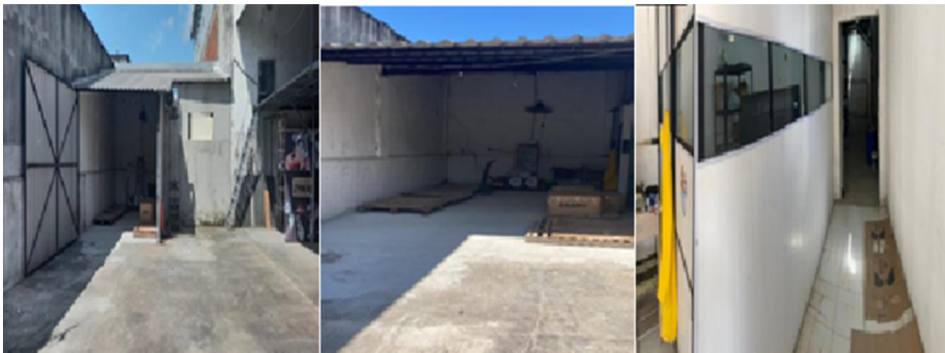
Figura 11- Figura de depois da construção do setor Recebimento. Fonte: Própria em 05/2023.
