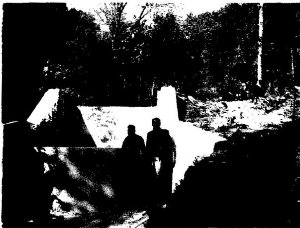
Fig. 11a. Drop spillway
