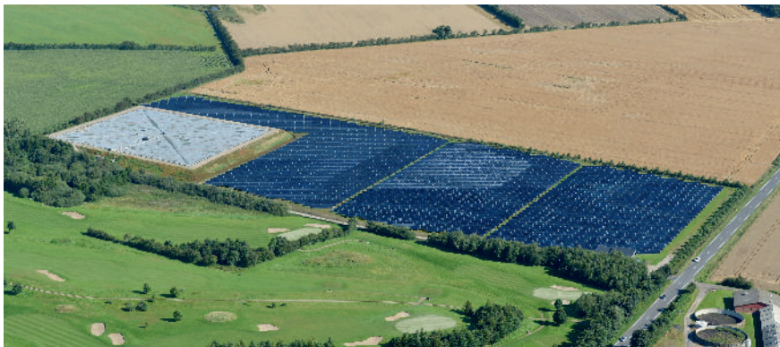
Bild 2 Erdbeckenspeicher in Tofund, Dänemark [5].
