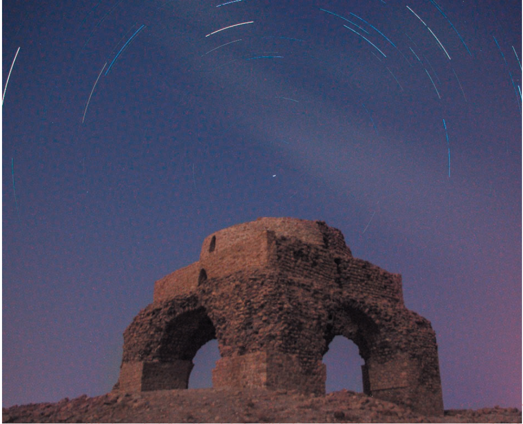
Fig. 26: Los Chartaqi están muy bien orientados. Son una estructura que consta de cuatro pilares orientados según los puntos cardinales, y cuatro arcos que sostienen una cúpula (Crédito Hosein).
