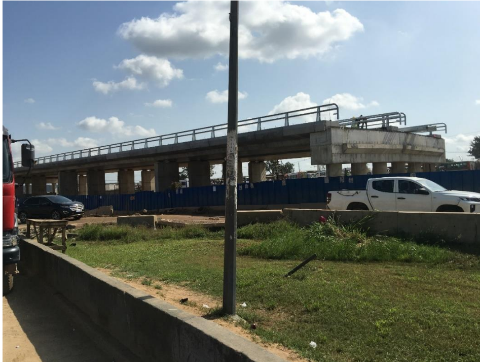
Photo 1 : Le pont de N'Dotré en cours de réalisation dans la commune d'Abobo
