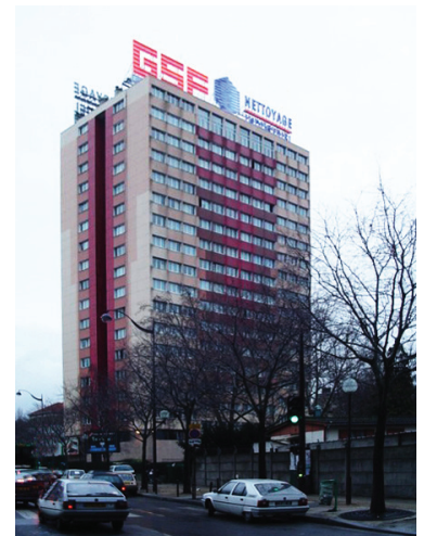
Fig. 07 TECTEAM, rehabilitation of the Bois-le-Prêtre tower (1990), Paris.
