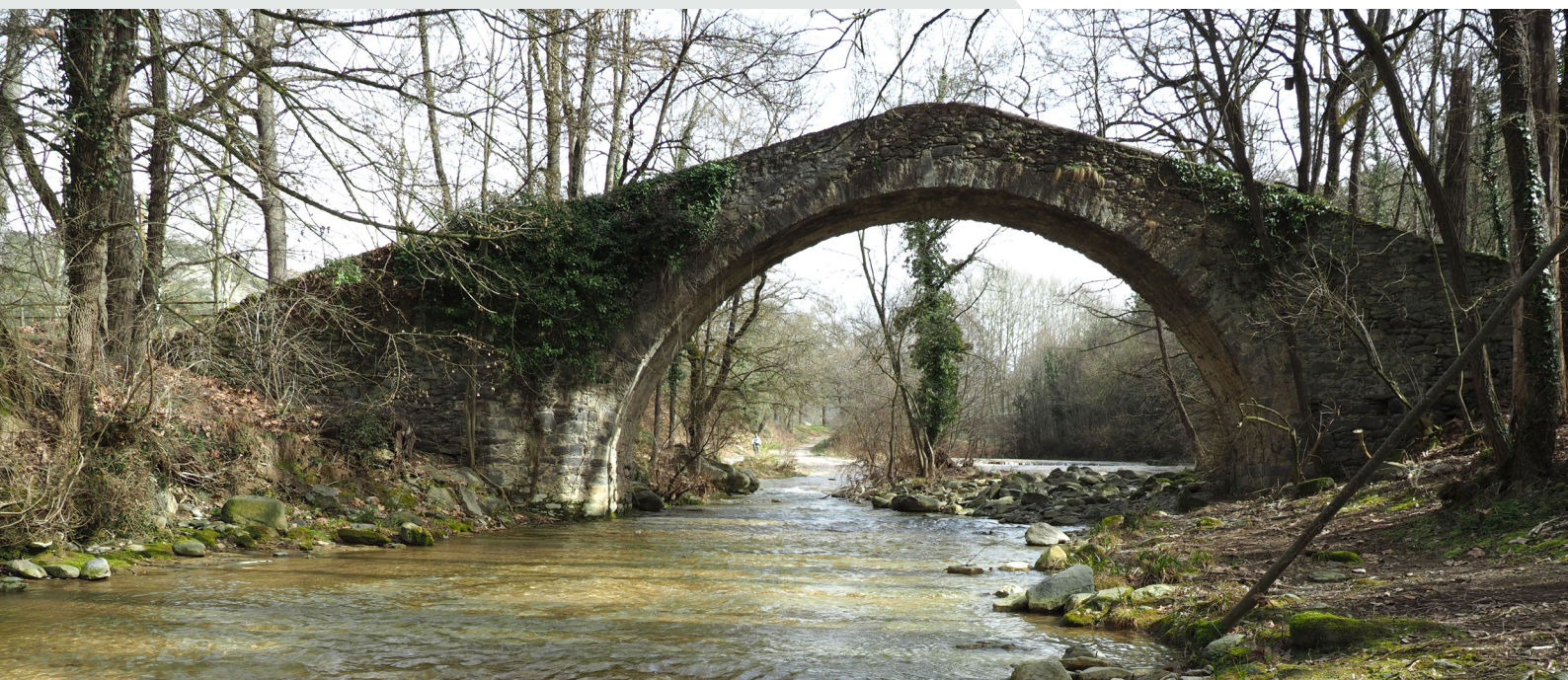
Pont medieval sobre el riu Ges (conca del Ter a Osona). Es un exemple de construcció adaptada a les crescudes del riu. La seva volta àmplia permet el desguàs de les riuades, fet que li ha facilitat arribar sencer fins avui en dia / Foto: Jordi Camprodon.
