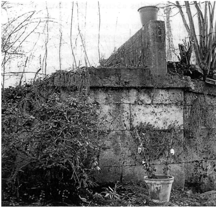
Detail des ehemaligen Kanaldamms: Abschluss des Kanaldamms aus Tuffquadern am Übergang zum oberflächigen Wasserrad.
