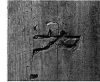
Abbildzeichen an Fachwerkständern der 1778 ergänzten Ost-Querwand.
