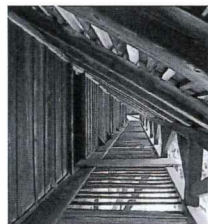
Ausragender Tröcknerost und Aufschieblinge.
