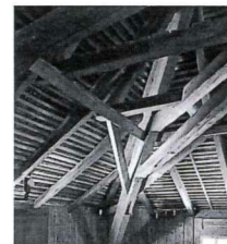
Detail des südwestlichen Walmgrat-Abbinds.
