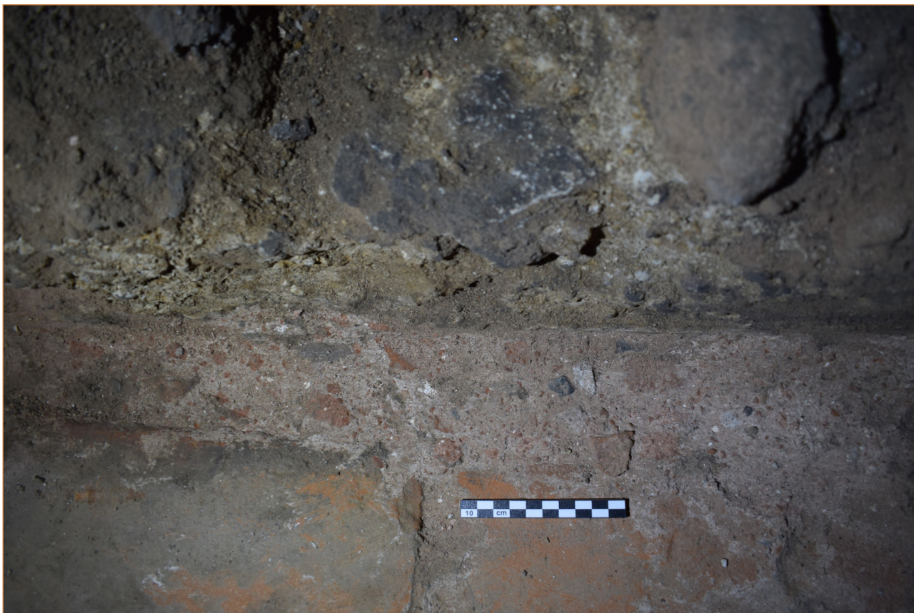
fig. 4. Parona (Verona), tratto in galleria dell'acquedotto: particolare del cocciopesto idraulico che rivestiva il canale originario.
