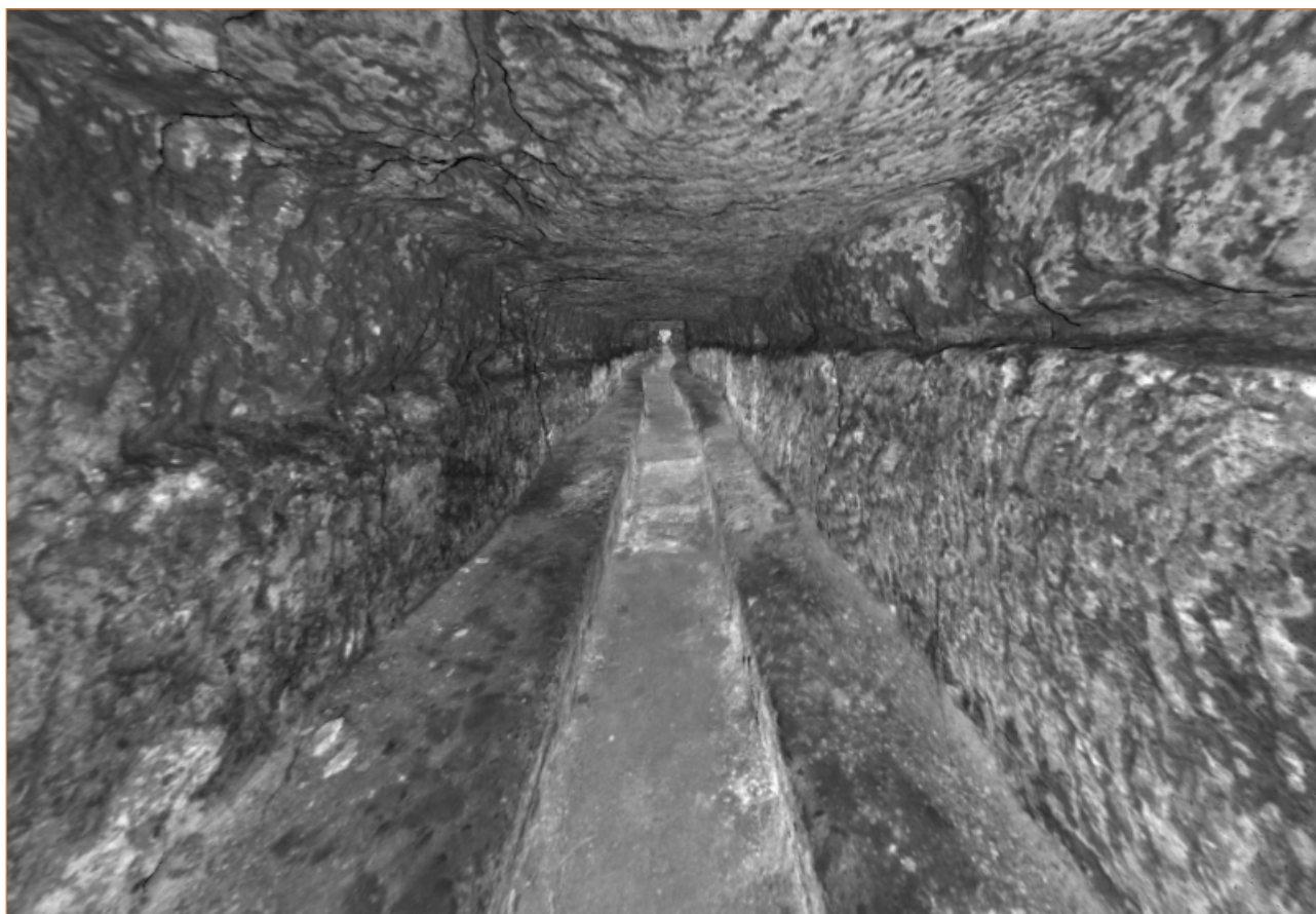
fig. 7. Parona (Verona), tratto in galleria dell'acquedotto: rilievo 3D (2022, Ianus Soc. Coop.).
