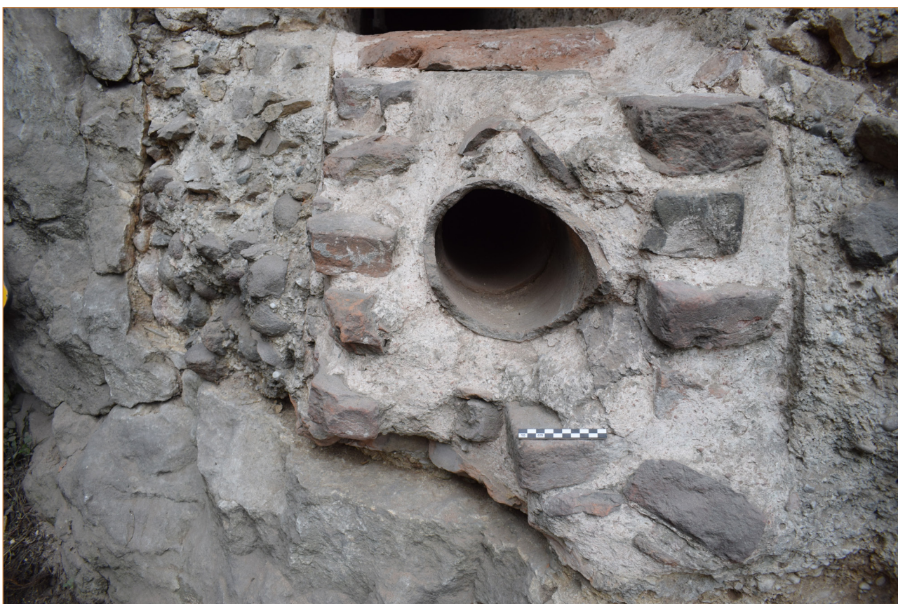
fig. 5. Parona (Verona), tratto in galleria dell'acquedotto: sezione tagliata dalla SPI, lato nord.
