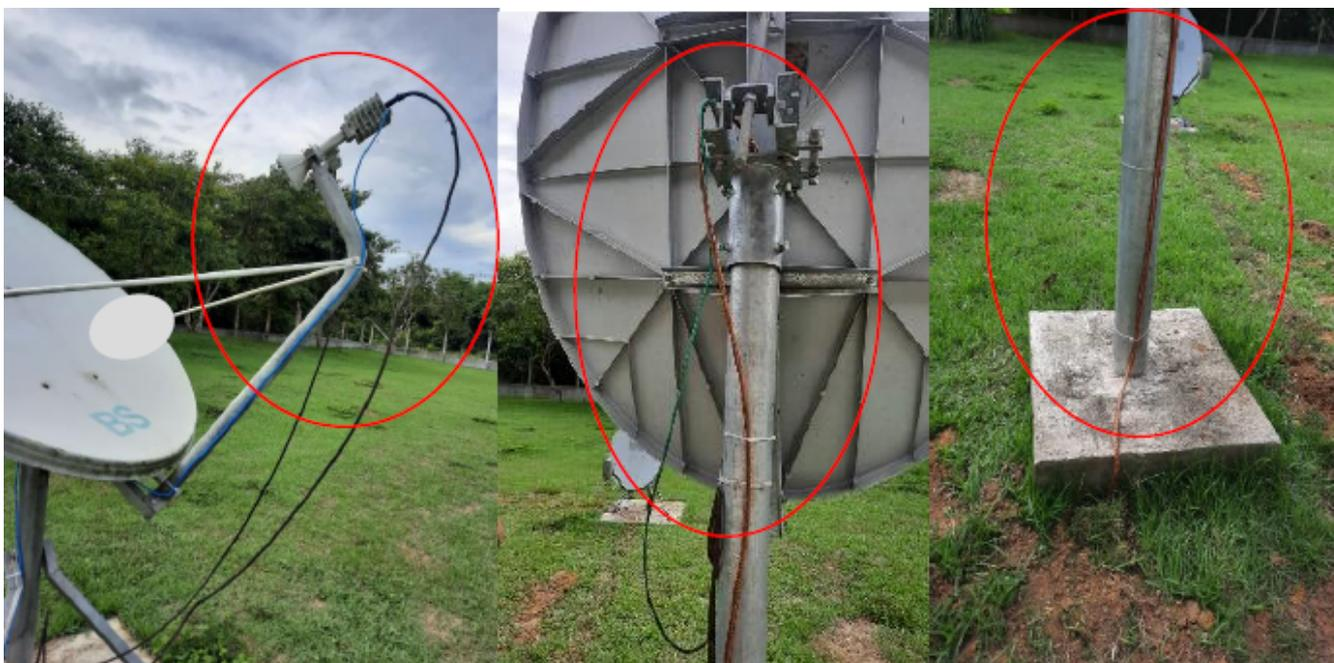
Esses novos cabos instalados (figura 18) foi para interligar esse ponto até a malha principal da usina.
