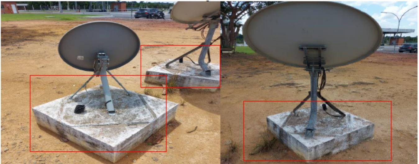
Com essa informação foi feita escavação (figura 14) ao redor para verificar se a malha de aterramento estava instalada corretamente conforme as normas da ABNT. E o ponto utilizado para a medição de continuidade entre a malha de aterramento existente e a malha de aterramento em execução na estrutura de antena, não foi identificado continuidade entre as malhas.
