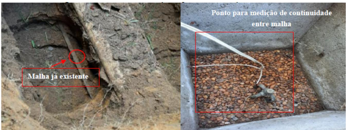
Após não identificar a continuidade entre as malhas, foi feito teste na parte do retorno da usina (figura 15), no ponto deixado no projeto para interligação das malhas, ponto encontrado fora da interligação, causando diferença de potencial
