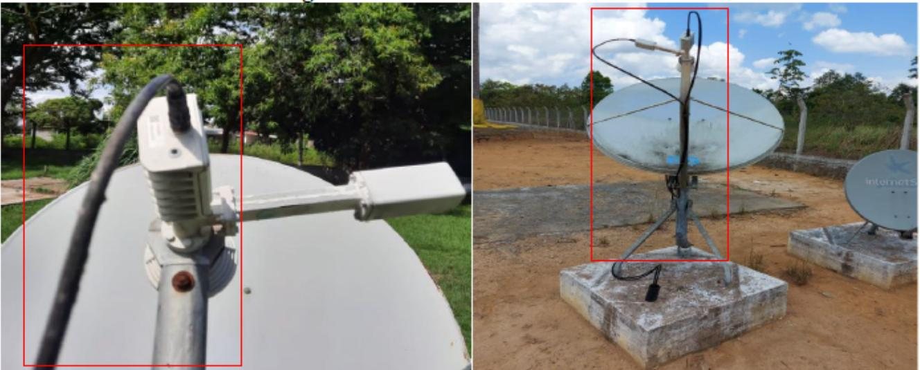
Foi observado pelos funcionários ao se sentarem na base, onde está instalado a antena que recebeu a descarga atmosférica (figura 13), ao tocar na antena sem os IPI, sem a proteção nos pés, percebeu a tensão que vinha do solo. Então foi analisado e observado, se a base está aterrada e a antena também e no mesmo
