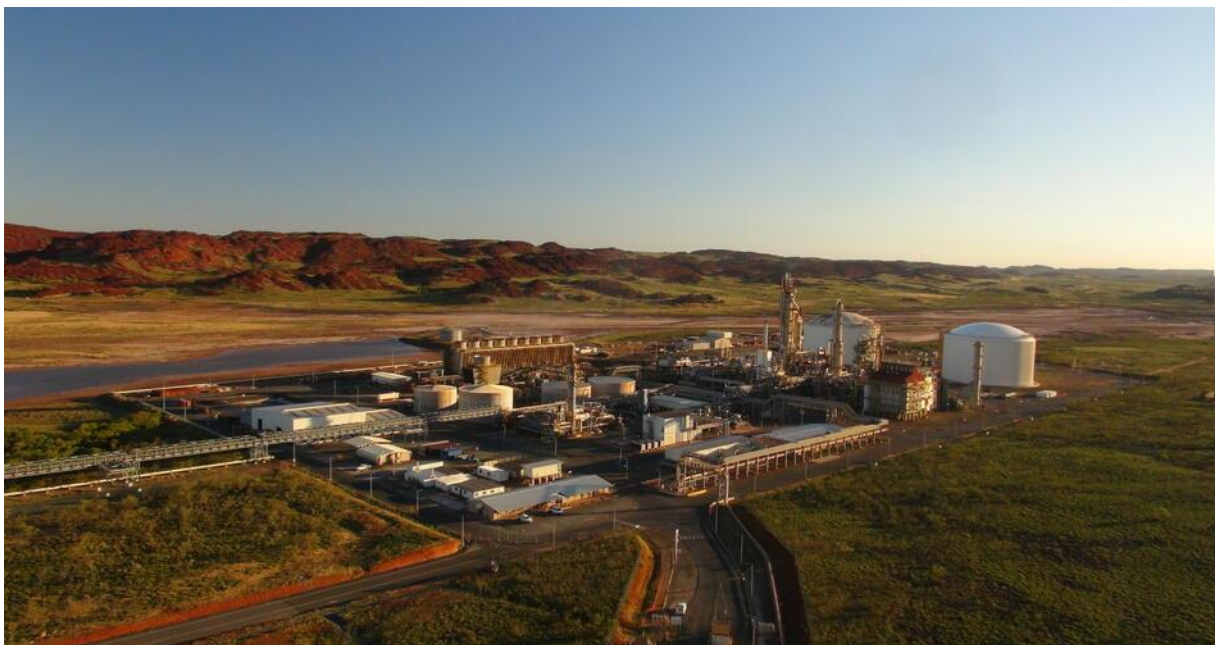
Abb. 53: Yaras „renewable hydrogen to ammonia“-Anlage für die Produktion CO 2 -neutraler, „grüner“ Düngemittel, Pilbara, West-Australien (Foto: Yara)
