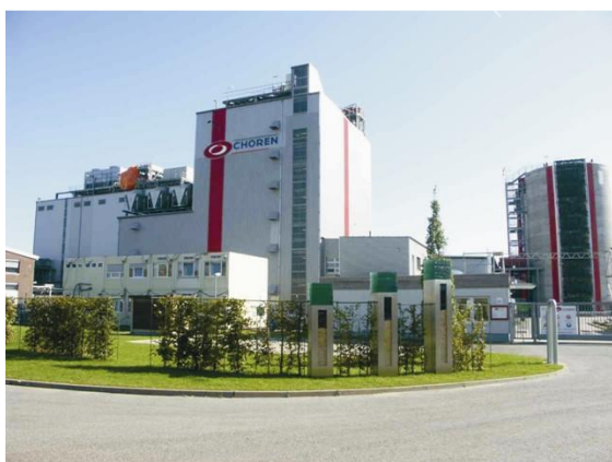
Abb. 19: 60 MW FWL Sauerstoffvergasungsanlage für Biomasse der Fa. CHOREN, Freiberg, 2007
