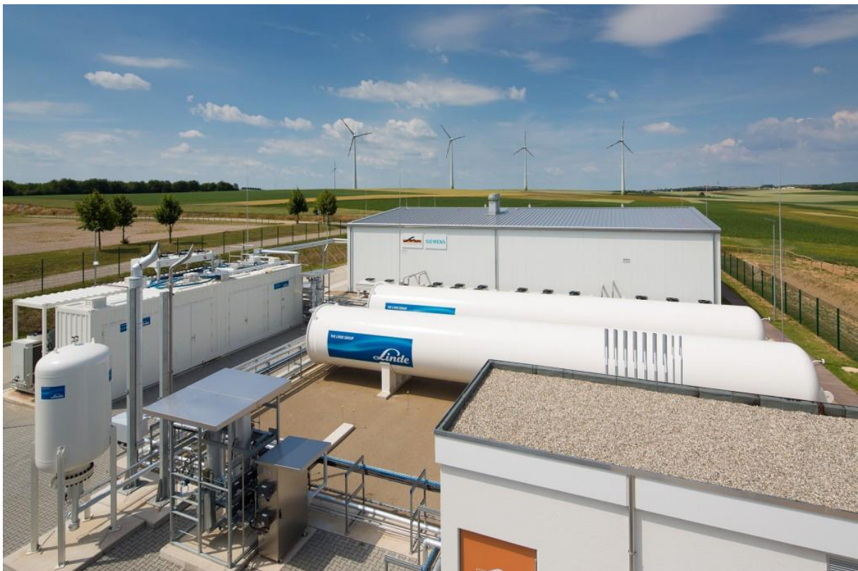
Abb. 7: Energiepark Mainz mit Siemens PEM-Elektrolyseur (Pressefoto Siemens 9 )
