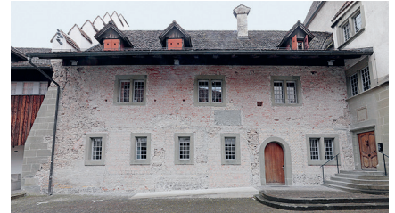
2 Die Nordfassade der Halle mit Backstein- und Tuff-Sichtmauerwerk von 1200. Alle heutigen Fenster und die Tür sind nachträglich eingebaut worden. © Marco Amstutz, ADB.
