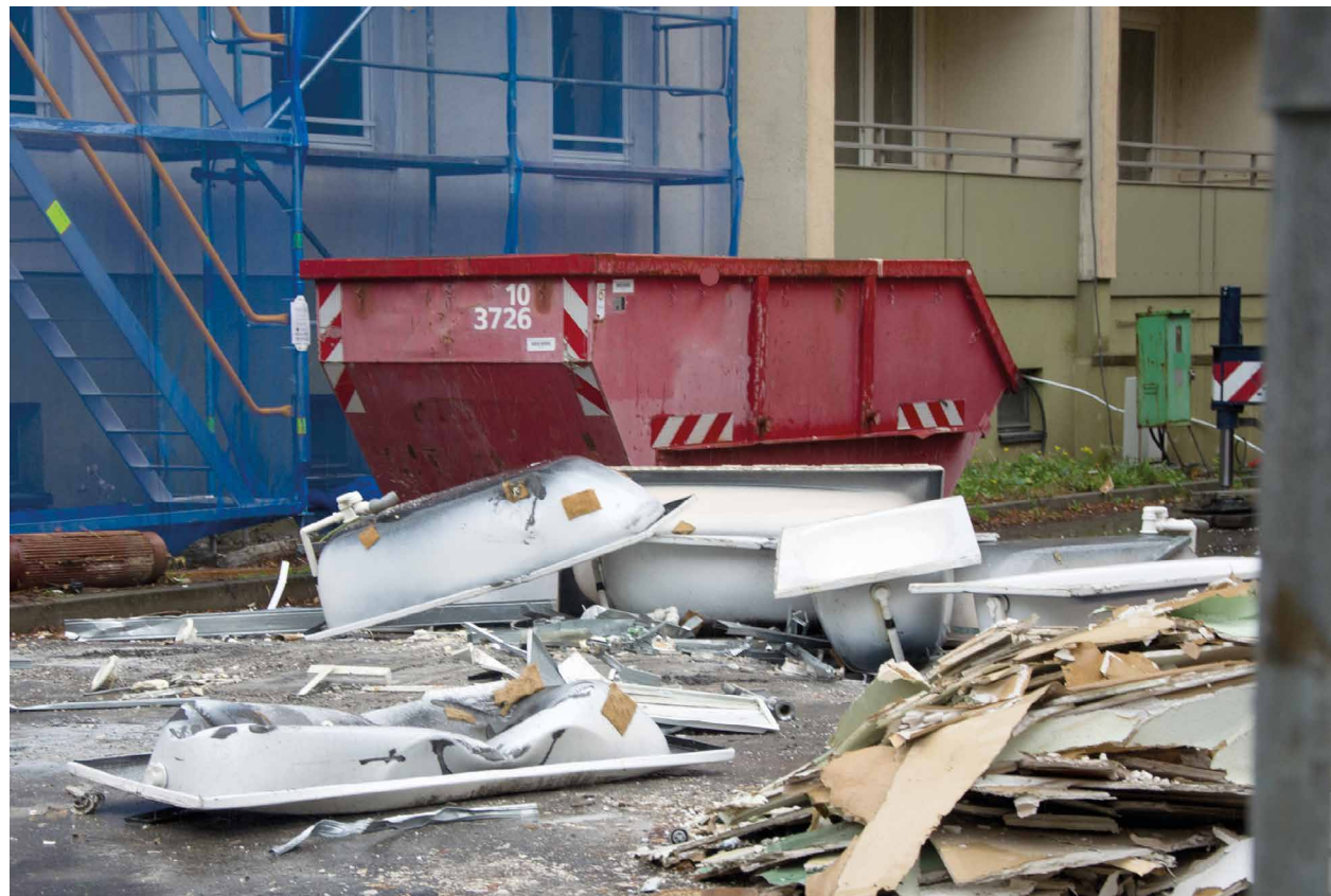
Konventionelle Abbruchbaustelle Dresden
