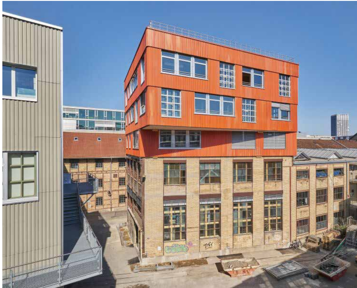
K.118 – Kopfbau Halle 118 baubüro in situ Winterthur (CH) 2021
