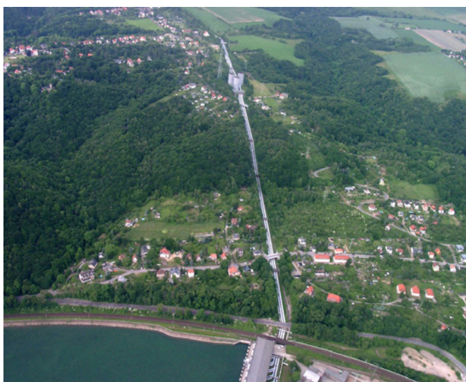
Pumpspeicherwerk Niederwartha: am unteren Bildrand das untere Staubecken und das Maschinenhaus. Gut zu erkennen ist die Wasserleitung zwischen beiden Becken mit den drei Wasserschlössern (Bild: Henry Mühlpfordt, GFDL oder CC BY SA 3.0, 2006)
