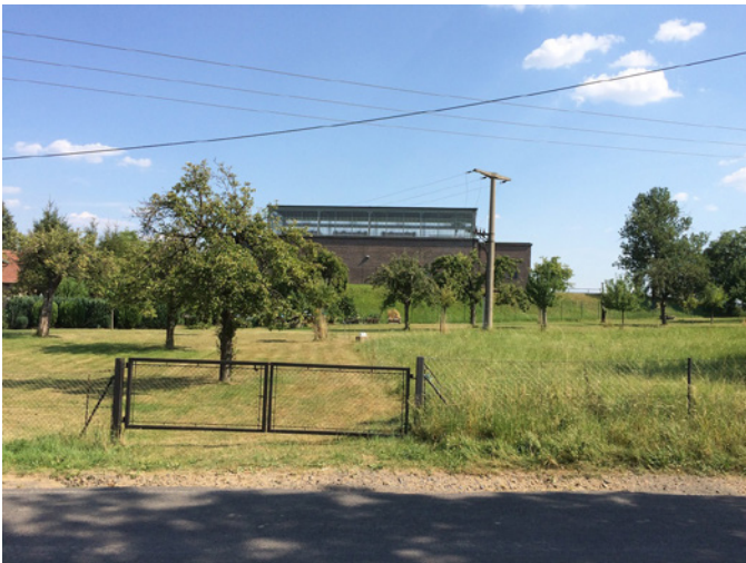
Pumpspeicherwerk Niederwartha: das Einlaufbauwerk in Oberwartha mit umlaufendem Oberlichtband (Bild: Printer07, CC BY NC 2.0, via flickr, 2015)
