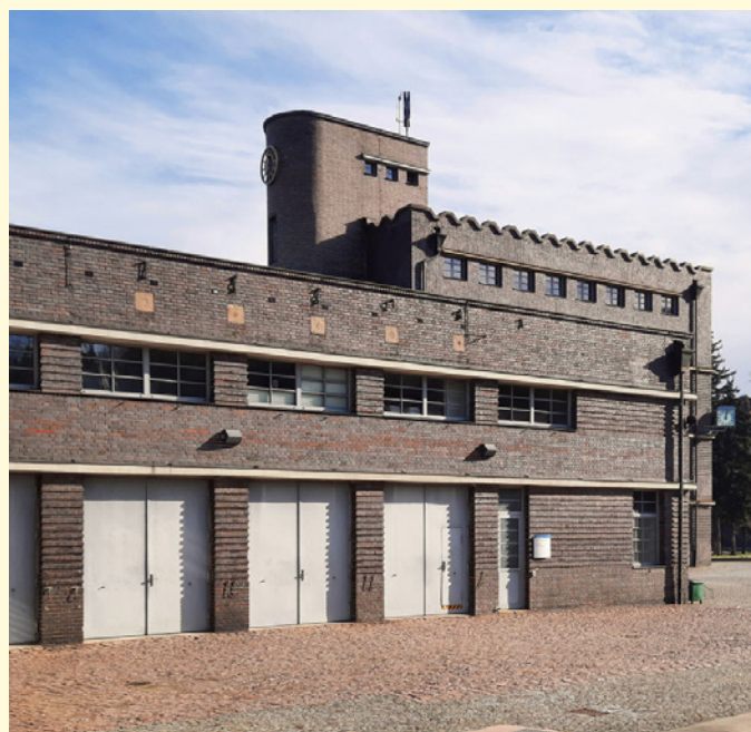
Pumpspeicherwerk Niederwartha: Werkstattgebäude im Vordergrund, direkt dahinter das Haus für Verwaltung und Schaltwarte. Im Hintergrund rechts sieht man das Maschinenhaus. Gut zu erkennen sind der Dekor der Klinkermauern sowie die ondulierte Dachkanten des Verwaltungs- und Maschinenhauses (Bild: Christian Gebhardt, CC BY SA 4.0, 2022)
