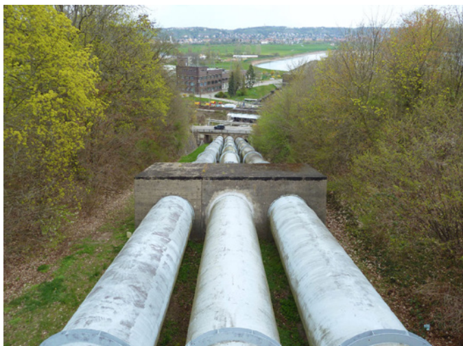
Pumpspeicherwerk Niederwartha: die drei Röhren der Wasserleitung zwischen dem oberen und dem unteren Gewässer. Eine dritte Röhre wurde nachträglich hinzugefügt (Bild: Derbrauni, CC BY SA 4.0, 2021)
