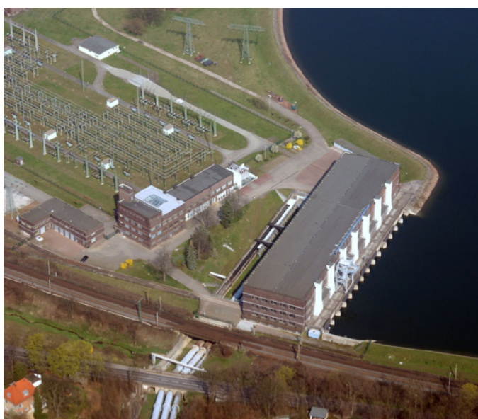
Pumpspeicherwerk Niederwartha: Luftbild des unteren Staubeckens. Das Maschinenhaus steht direkt am Wasser. Links im Bild: das Werkstattgebäude sowie die Verwaltung/Schaltwarte. Gut zu erkennen sind ebenfalls die Masten der Umspannanlage (Bild: Carsten Pietzsch, CC0 1.0, 2004)
