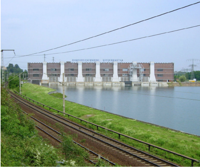
Pumpspeicherwerk Niederwartha: wasserseitige Längsansicht des Maschinenhauses. Die von 1957 bis 1960 hinzugefügten Gebäudeachsen befinden sich rechts, der Farbton ist hier minimal heller und rötlicher (Bild: ProfessorX, GFDL oder CC BY SA 3.0, 2004)
