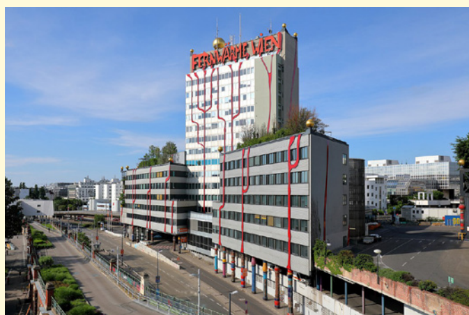
Wien, Müllverbrennungsanlage Spittelau (Bild: C. Stadler/Bwag, CC BY SA 4.0, 2020)
