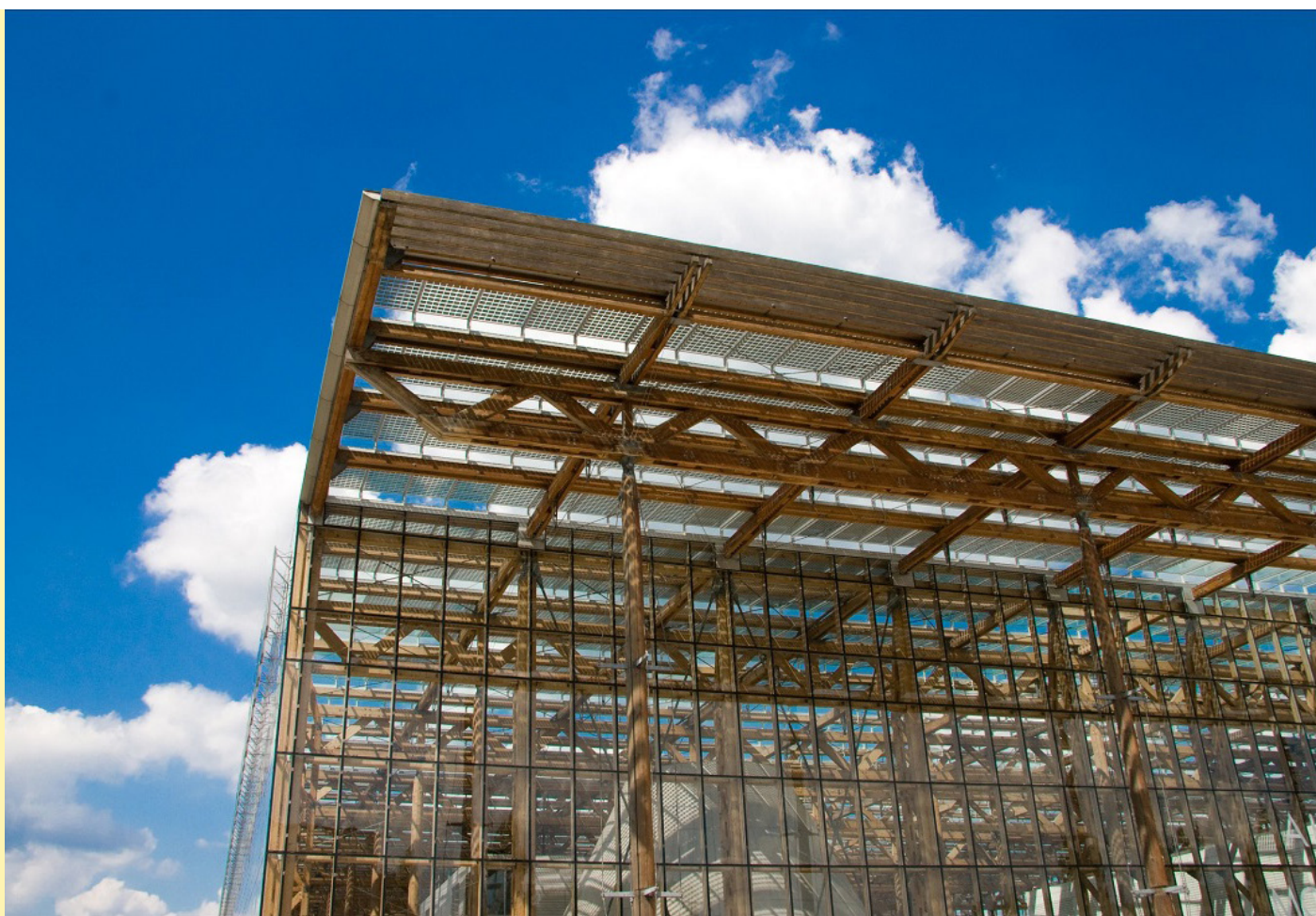
Herne-Sodingen, Akademie Mont-Cenis, Fotovoltaik-Module im vorkragenden Hallendach (Bild: Nils Apfelbaum, CC BY NC SA 2.0, via flickr, 2007)
