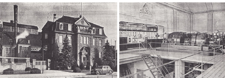
Luckenwalde, E-Werk, Fassade (links) und Turbinenhalle, um 1928 (Bild: E-Werk Luckenwalde)
