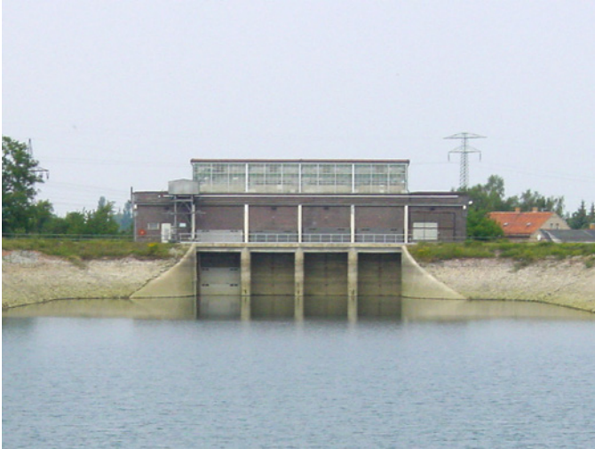
Pumpspeicherwerk Niederwartha: das obere Staubecken und das Einlaufbauwerk mit umlaufendem Oberlichtband (Bild: ProfessorX, GFDL oder CC BY SA 3.0, 2004)
