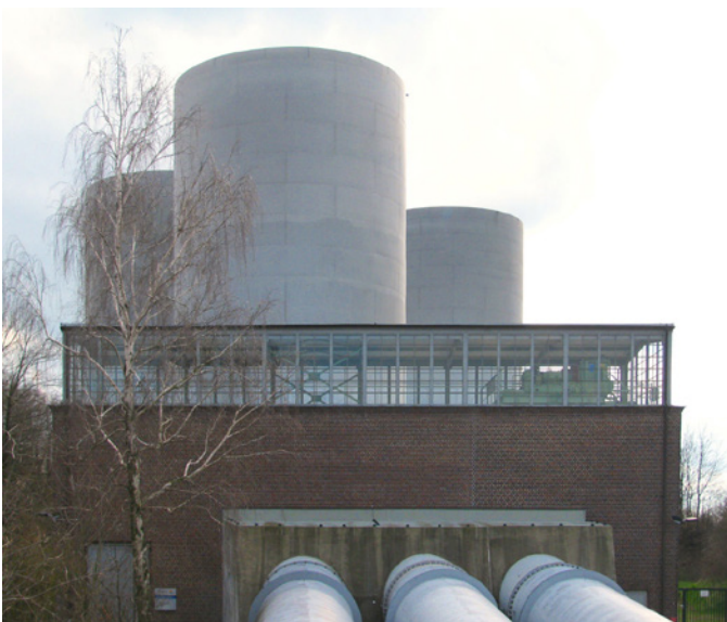
Pumpspeicherwerk Niederwartha: das Schieberhaus mit umlaufendem Oberlichtband, dahinter die drei Wasserschlösser (Bild: DynaMoToR, CC BY SA 3.0, 2010)
