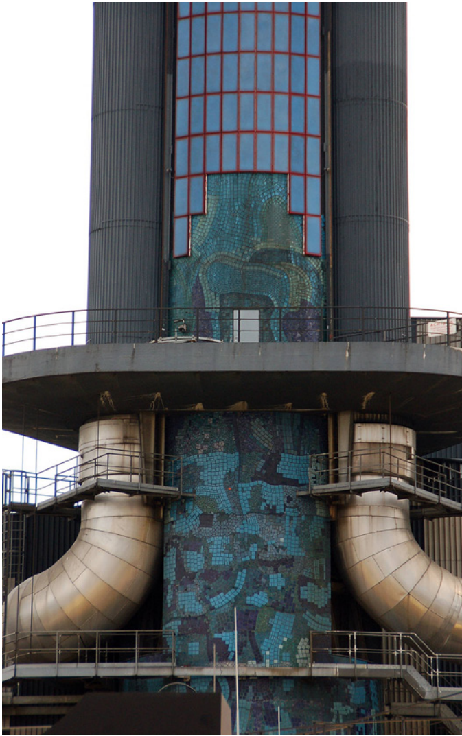
Wien, Müllverbrennungsanlage Spittelau (Bild: Keith Ewing, CC BY NC ND 2.0, via flickr, 2012)
