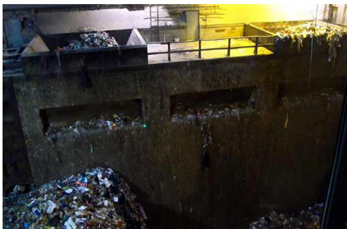
Wien, Müllverbrennungsanlage Spittelau (Bild: Paul Korecky, CC BY SA 2.0, 2017)
