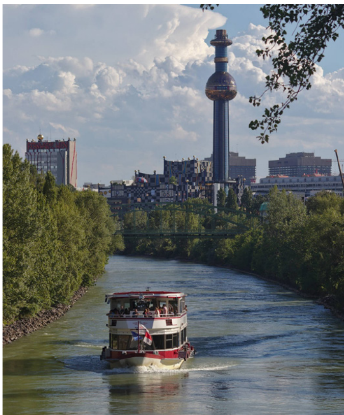
Wien, Müllverbrennungsanlage Spittelau (Bild: wdwd, CC BY 3.0 oder GFDL, 2011)
