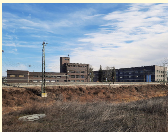
Pumpspeicherwerk Niederwartha: das Werkstattgebäude links, das Haus für Verwaltung und Schaltwarte mittig, das Maschinenhaus rechts (Bild: Christian Gebhardt, CC BY SA 4.0, 2022)
