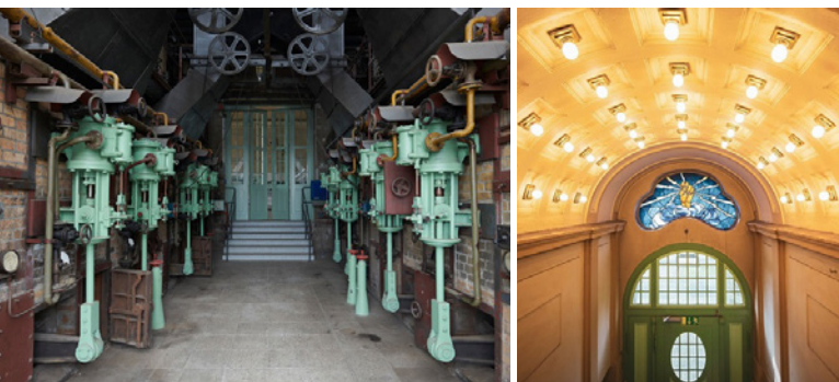
Luckenwalde, E-Werk, Kesselhaus (links) und Haupt- eingang mit Lünette (Bilder: links: E-Werk Luckenwalde, Ben Westoby; rechts: E-Werk Luckenwalde)
