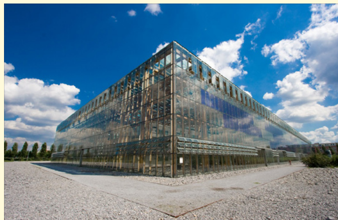
Herne-Sodingen, Akademie Mont-Cenis, Lüftungsschlitze sorgen für Frischluft und Kühlung (Bild: Nils Apfelbaum, CC BY NC SA 2.0, via flickr, 2007)
