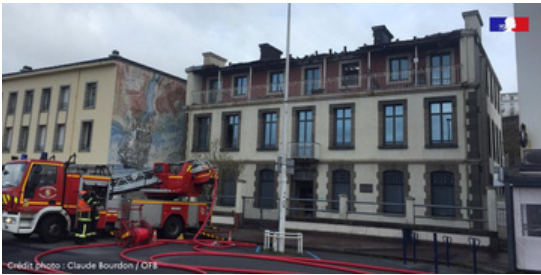
Pompiers intervenant suite à l'incendie des bureaux de l'Office Français de la Biodiversité à Brest (Bourdon / OFB, 2023)
