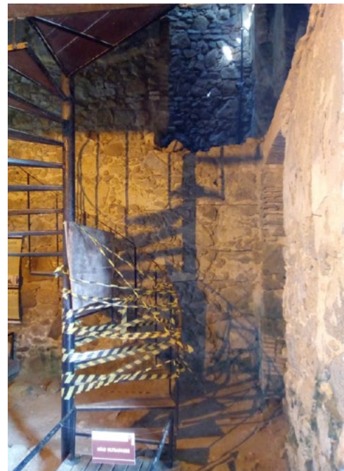
Figura 5 – Detalhe do interior da Casa do Comandante da Fortaleza de São José da Ponta Grossa, onde é possível observar diferentes materiais utilizados para o restauro
