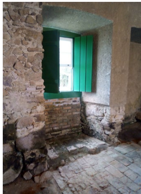
Figura 4 – Detalhe do interior da Casa do Comandante da Fortaleza de São José da Ponta Grossa, onde é possível observar diferentes materiais utilizados para o restauro
