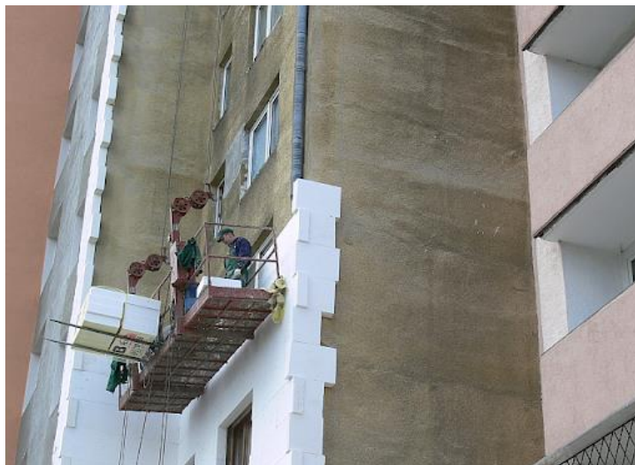
Fig. 17. Najbardziej popularny sposób termomodernizacji ścian budynków wielorodzinnych w Polsce.
