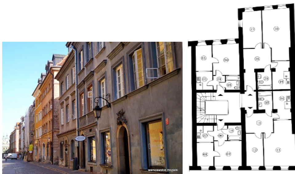
Fig. 18. Widok i układ przestrzenny zabytkowej kamienicy, ul. Piwna, Stare Miasto, Warszawa
