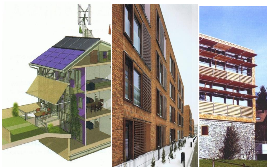
Fig. 43. Przykłady różnych zewnętrznych systemów zacieniających przeszklenia w budynkach; źródło [19].
