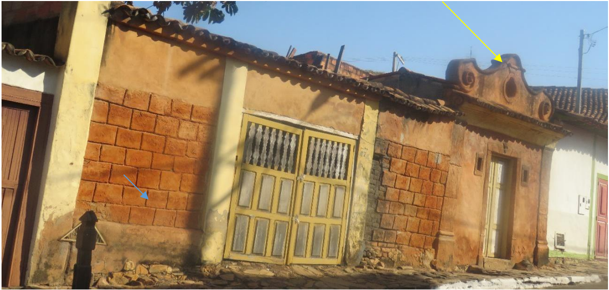
Figura 13: Fachada construída por ocasião da comemoração dos 200 anos de Paracatu. Fonte: Arquivo da pesquisadora. Fonte: Arquivo dos pesquisadores.
