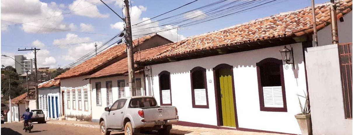
Figura 12: Vista parcial da Rua Goiás no sentido do início Da mesma. Imagem do acervo dos pesquisadores, 2022.
