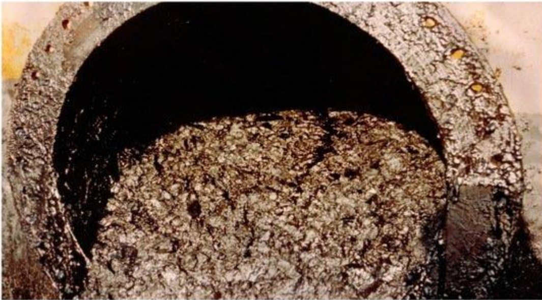
Şəkil 2. Rezervuara yığılmış neft şlamı
