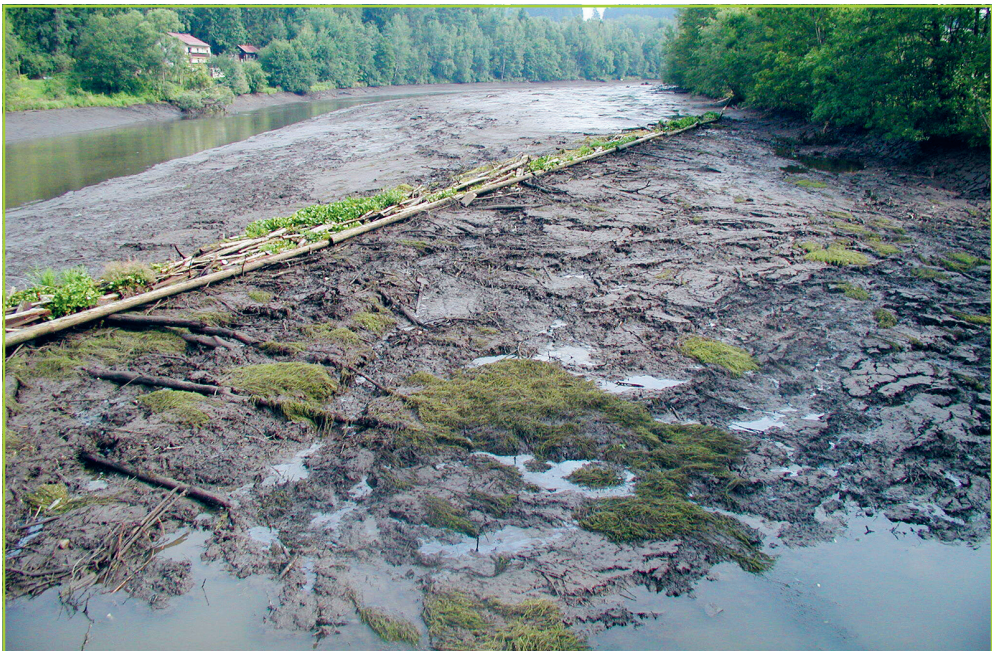
Abbildung 7-28: Der Stausee Regen weist massive Schlamm- und Feinteilablagerungen auf, die in abgesenktem Zustand sichtbar werden.
