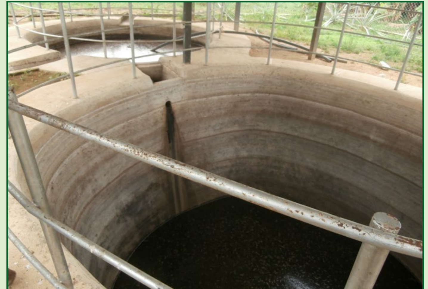
Producción y almacenamiento de purines proveniente de la sala de ordeño. Barinas, Venezuela
