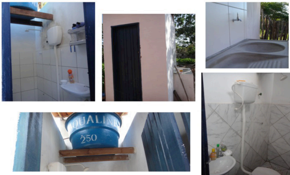
Foto N° 2. Banheiros individuais construídos na comunidade intervenção
