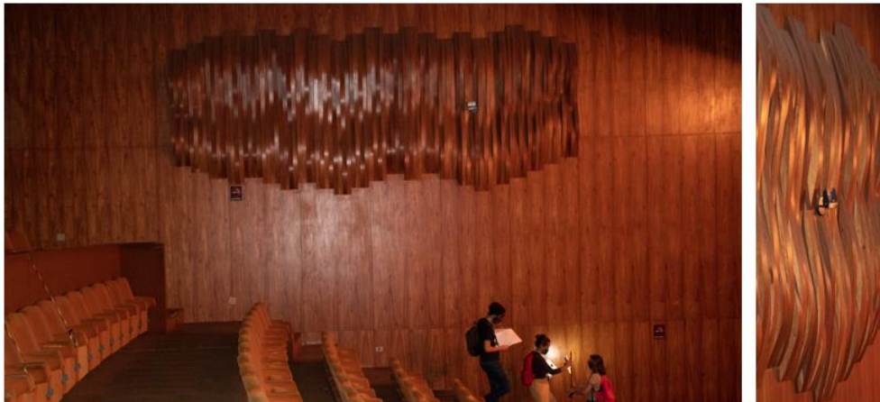
Figura 3 – Pannel de madeira – autoria Athos Bulcão – perfurado para instalar iluminação de emergência (fonte: acervo particular dos autores).
