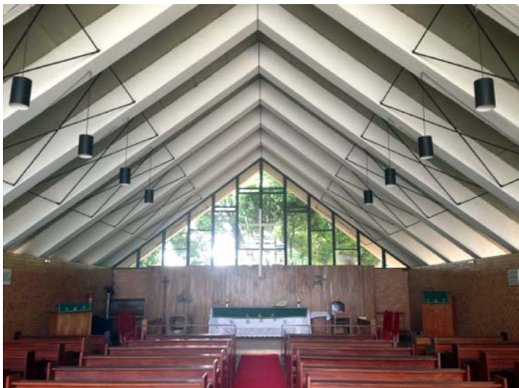
Detalhe do tirante e contraventamento
