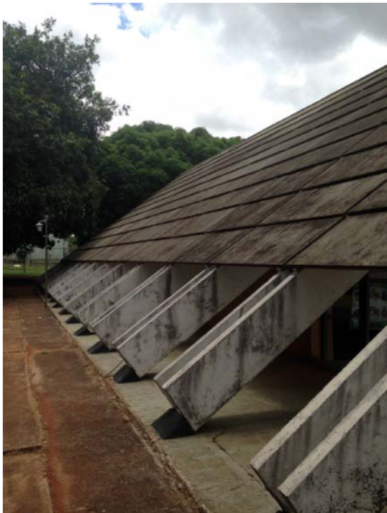
Detalhe da viga formato "U" e das placas de concreto pré-moldadas
