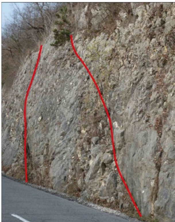
Fig. 59: Réseau de failles longitudinales dans les bancs calcaires de l'Urgonien blanc auct. le long de la D41A, entre Mornex et le réservoir à l'E de Monnetier.
