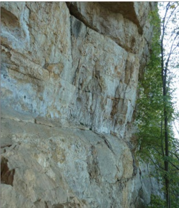
Fig. 77: Kink dans les calcaires de la Formation de Pierre-Châtel, au-dessus de l'entrée de la Grotte d'Archamps (à la base des Rochers d'Archamps).
