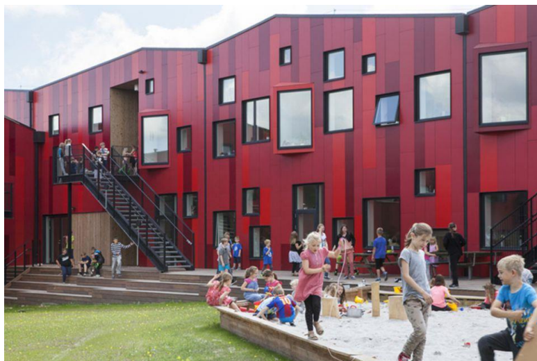
Рис. 2. Фрагмент фасада «Умной школы» со стороны внутреннего двора
