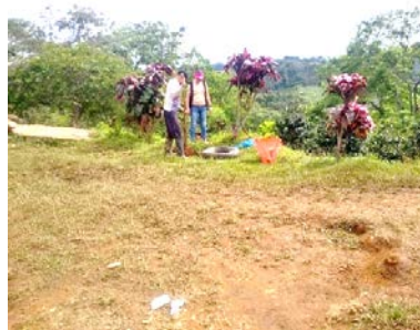
Figura 7. Proceso de construcción del parque
