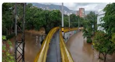
Figura 3. Desbordamiento de la quebrada La Presidenta [8]
