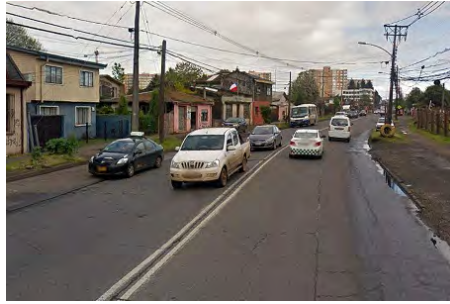
Figura 3. Calle Pedro de Valdivia pre- mejoramiento
