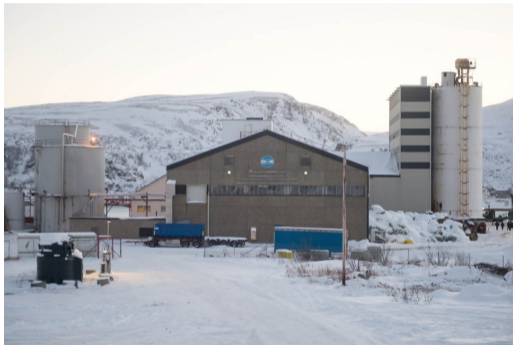
Liholmen Biogas plant in Båtsfjord
