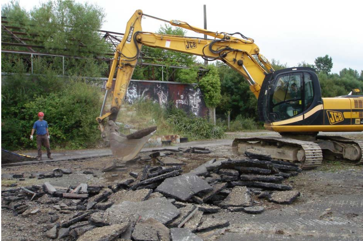
Desealing in progress in Saint-Nicolas du Redon carried out by the association “Les amis du transformateur”. © Les amis du transformateur
