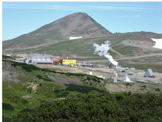
Рис. 2. Мутновская геотермальная станция (Южная Камчатка). Фото А. Мазуренко
