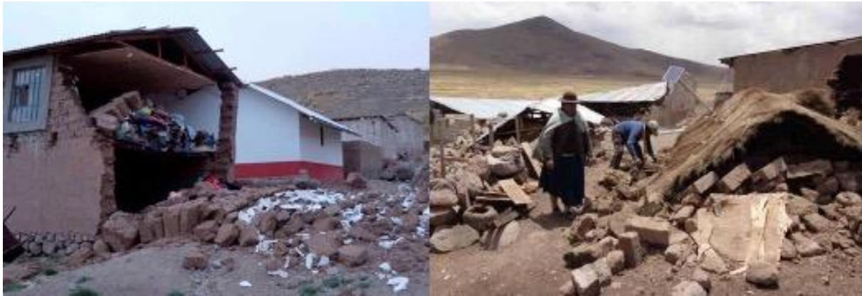
Figura 8. Daños suscitados por sismo, año 2016
