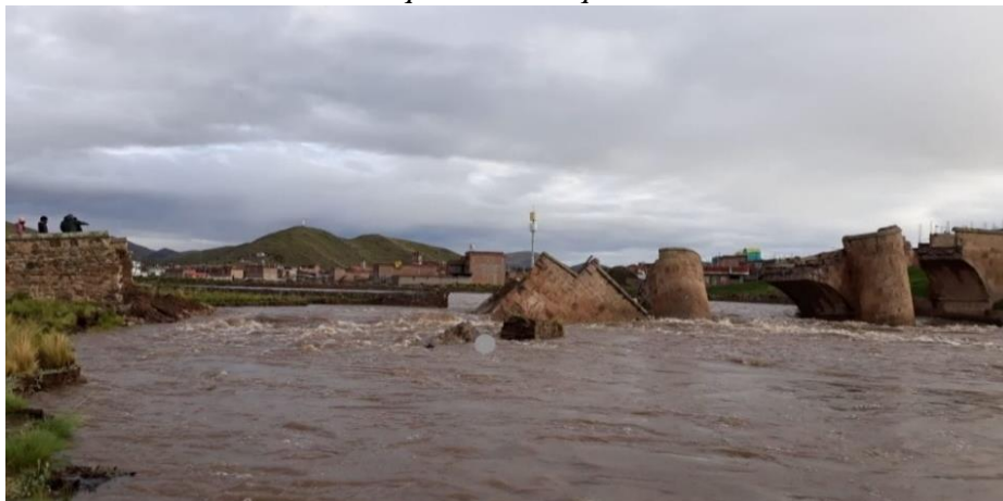
Figura 11. Colapso total del puente
