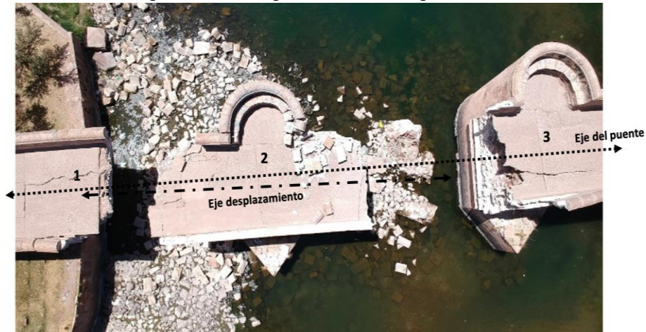
Figura 10. Esquema del desplazamiento del pilar central
