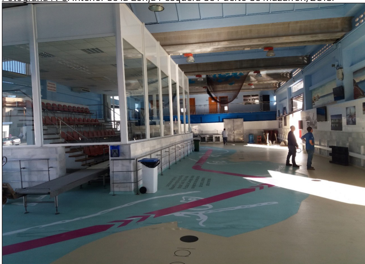
Fotografía N°8. Interior de la Lonja Pesquera de Puerto de Mazarrón, 2018.
