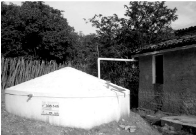
Figura 2 – Cisterna de placas de 16 mil litros construída no âmbito do Programa Cisternas
