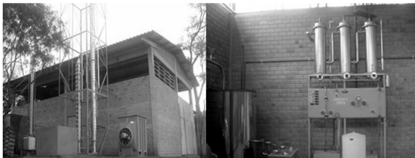
Figura 2 – Usina Piloto de Etanol da UFSM.
