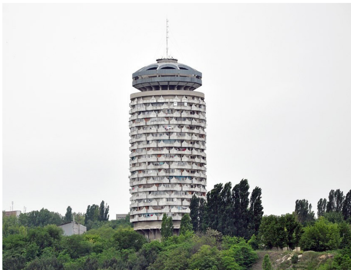
Fig. 12. Căminul cu 22 niveluri de pe str. Arheolog Ion Casian-Suruceanu, („Romanița”). Arhitecți Oleg Vronschi, Elena Zabunova. Sursa: https://locals.md/2020/10-zdaniy-kishinyova-v-kotoryh-stoit-pobyvat-kazhdomu/romashka_locals-5/ .
