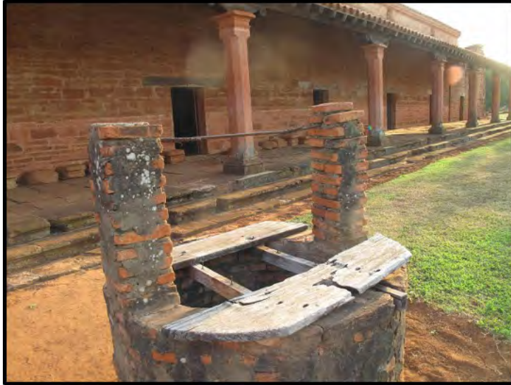
Foto N° 4. Reducción San Cosme y Damián, Itapúa, Paraguay. Aljibe en el patio central.
