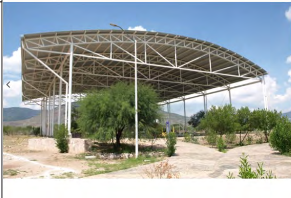
Fotografías N° 7y 8. Sistema de cosecha de agua de lluvia comunitaria. Centro deportivo y sistema de captación de agua de lluvia en el municipio de Tierra Blanca. Sis
