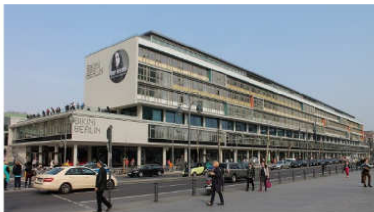
Das Berliner Bikinihaus wurde jüngst aufwändig saniert (Bild: indeedous)
