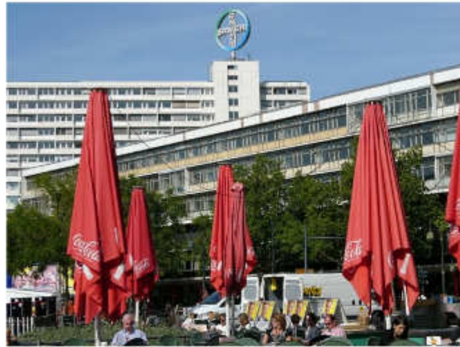
Spätestens seit den 1980er Jahren wurden das Bikini Haus hier 2009 vor der Sanierung und seine Umgebung mehr und mehr vernachlässigt (Bild: Johann Sauer, 2009)
