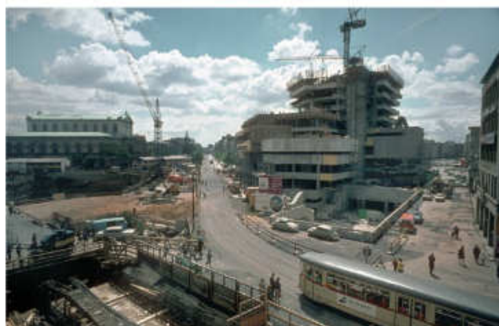
Um 1976 war der Kröpcke eine Großbaustelle (Bild: Hist. Museum Hannover)
