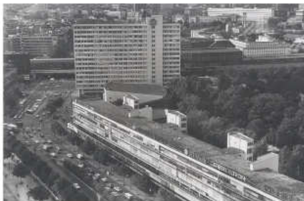
Ein langgestrecktes Geschäftshaus mit Produktionsstätten, Läden und Kneipen (Bild: Archiv Paul Schwebes, vor 2009)
