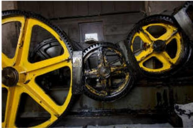
*Typische Polygonräder im Triebwerksraum eines Paternosters (Bild: A. Halada)*
