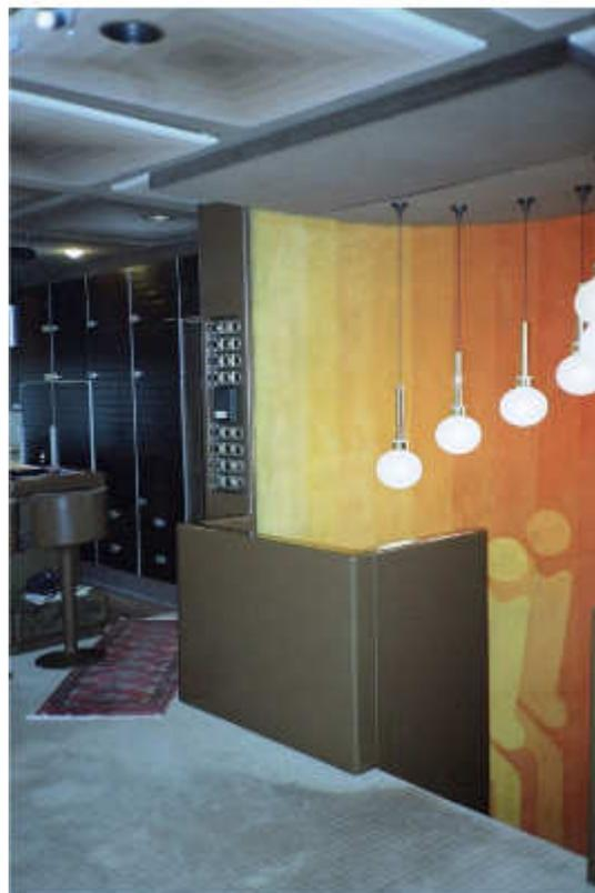
Bei beiden fg 2000-Häusern krägt der leicht gewölbte, sanft gerundete GFK-Korpus im Obergeschoss vor. Der Prototyp setzte sich aus nur zwei Modulen zusammen: Wand- und Dachelement. Beim Wohnhaus kam noch die Positiv- bzw. Negativecke hinzu. Der Innenausbau erfolgte über textilbespannte gedämmte Holztafeln. Im stützenlosen Wohnraum konnten die nichttragenden Innenwände dann nach Belieben verortet werden.
