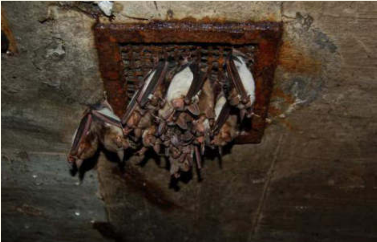
Berlin, Flakbunker-Ruine, Humboldthain, überwinternde Fledermäuse (Bild: Holger Happel)
